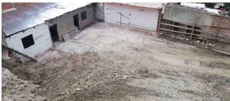
Figura 12 foto referencial inicio de obras preliminares
