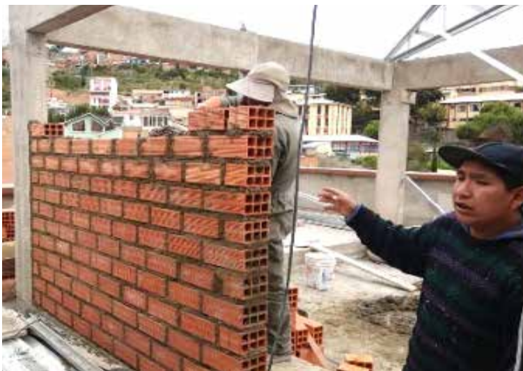
Figura 13 foto referencial de obra gruesa
