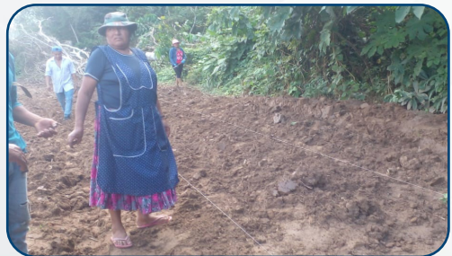
Sistema Semi-mecanizado (romploneado y rastreado con tractor agrícola)
